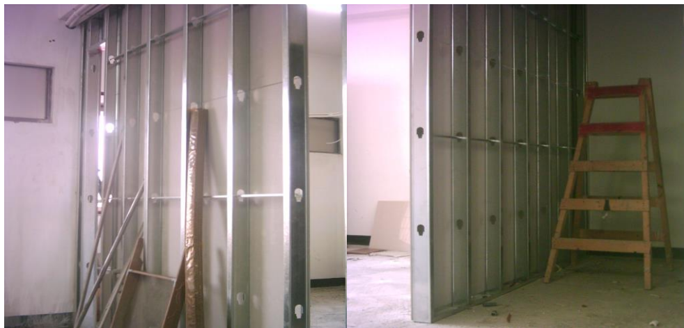
照片 1 輕型鋼構隔間
