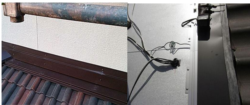
照片3-5 東京都民宅屋頂
