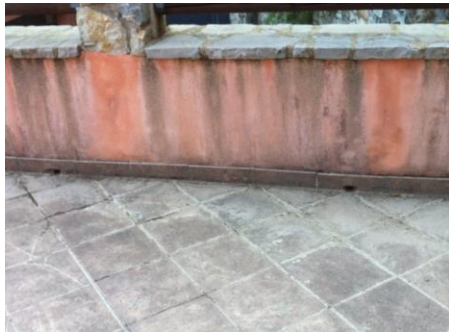
照片3-7 東京都〇〇建築屋頂
