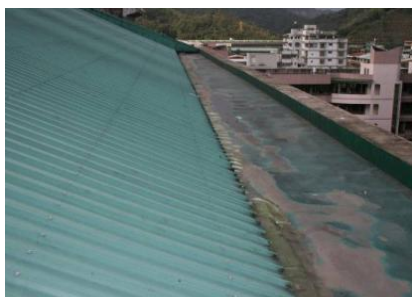
照片3-3 鋼構斜屋頂天溝
