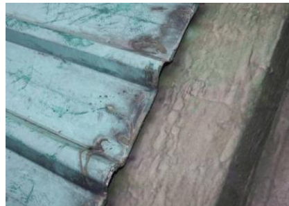
照片3-4 鋼承板與支承梁
