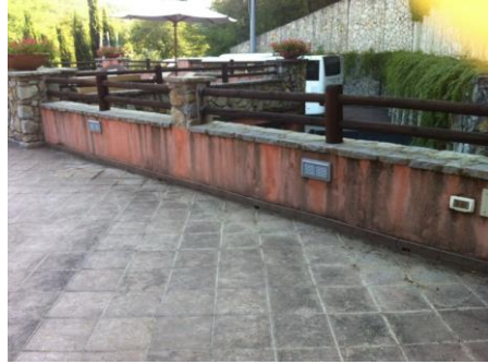
照片3-8 東京都〇〇建築屋頂
