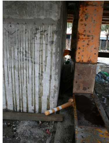
圖 四 橋墩基礎完成灌漿作業
