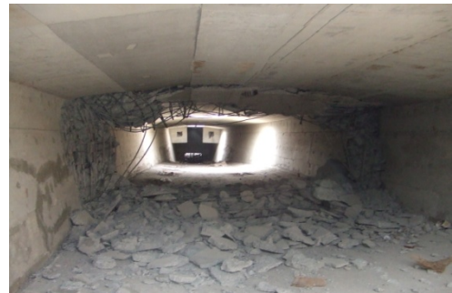
圖二 箱型預力梁局部挫屈情形
