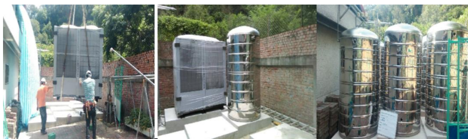
照片 1:新型熱泵系統安裝
