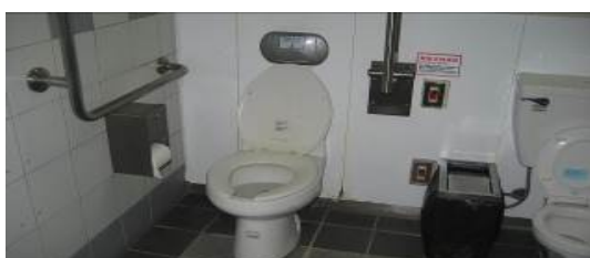
圖 5、廁所內迴轉空間不足
