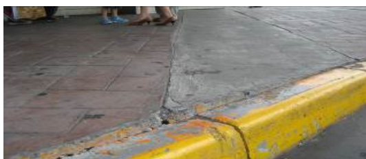
圖 3、引導通路高低差及路面不平
