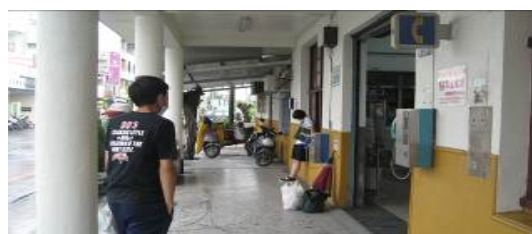
圖 10、室外引導通路突出物過多，且未設警示
