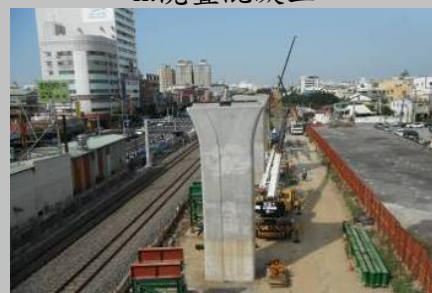
j. 完成墩柱
