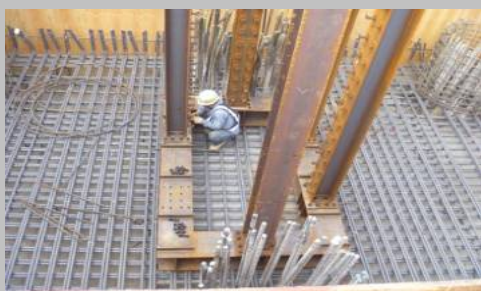
c. 型鋼底座定位
