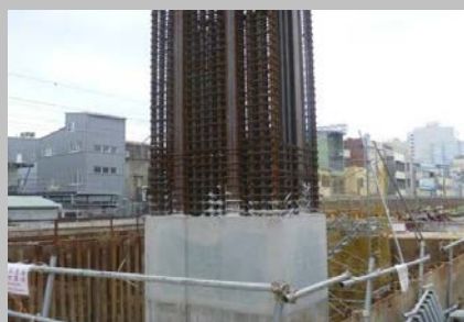
i. 橋墩伸層澆置
