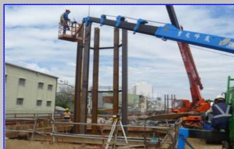
d. 吊裝型鋼
