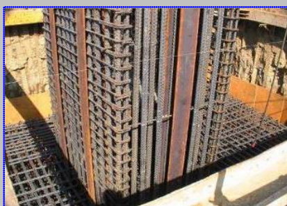
g. 綁紮基礎及墩柱鋼筋
