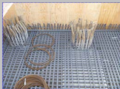
b. 綁紮基礎底層鋼筋
