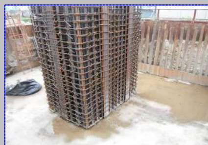
h. 澆置混凝土
