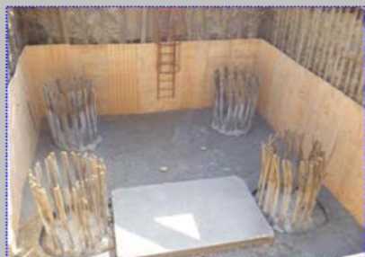
a. 施作基礎混凝土墊塊
