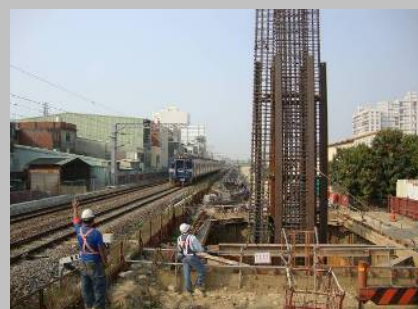
f. 吊放預組鋼筋籠
