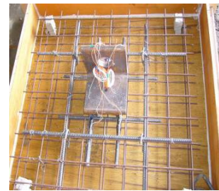
(c) (56E)接頭試體鋼筋擺設
