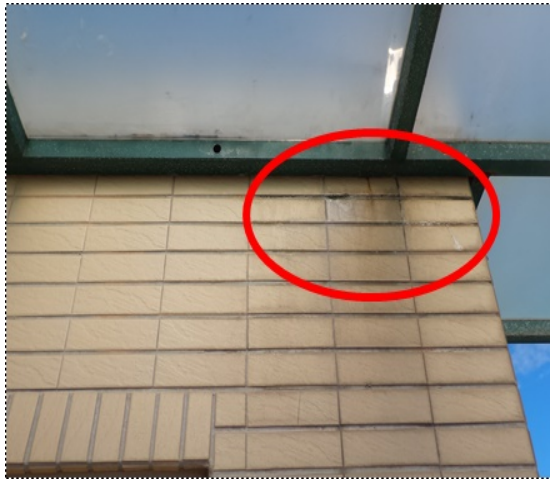
圖11 實地檢測A案外牆面
