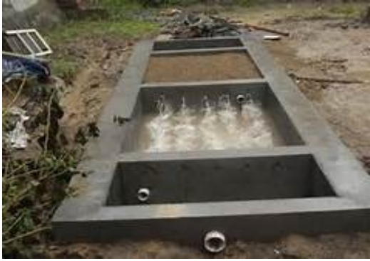
圖3 污水處理設施—現場構築 (網站節錄圖片)
