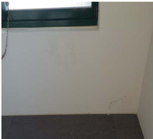
圖9 實地檢測C案現況照片
