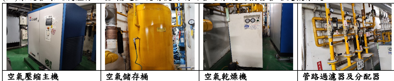
圖4.1 壓縮空氣系統設備圖
