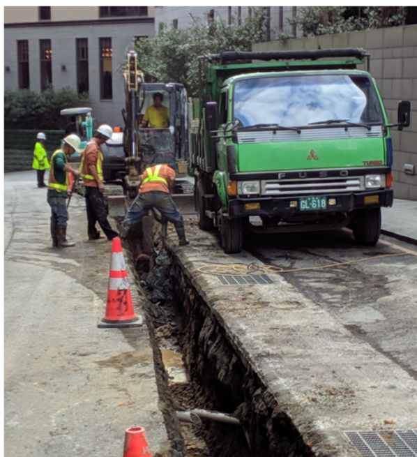
圖 2 路面管溝開挖照片
