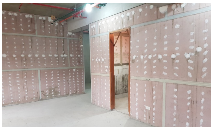
圖 6 輕隔間牆(濕式)-可拆除
