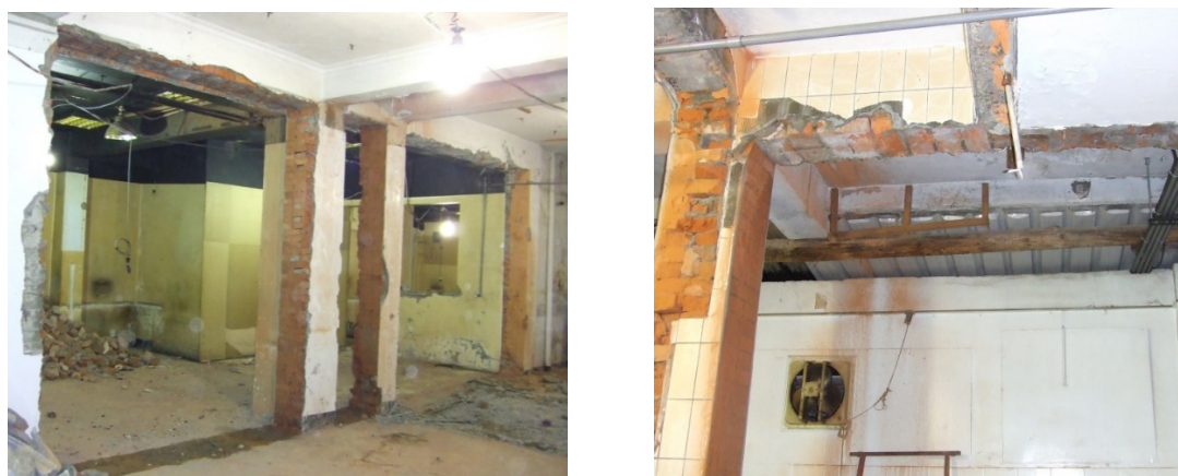
圖 4 加牆磚造牆已被拆除-不可拆除
