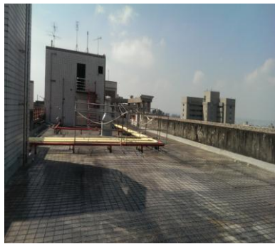
圖 3-10 點焊鋼絲網鋪設
