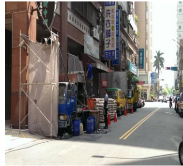
圖 3-11 泡沫混凝土灌漿
