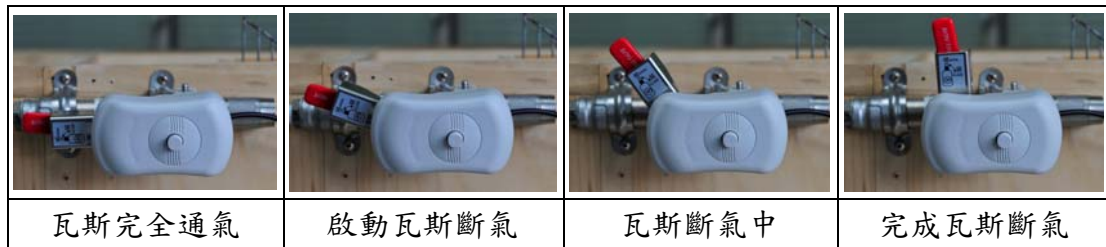
圖 15. 瓦斯切斷器轉 90 度切斷瓦斯供應畫面
