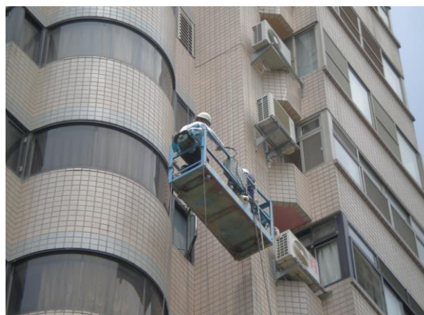
圖 7 吊掛作業圖(洗窗機)
