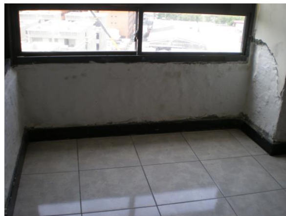
圖 11 塗佈抗負水壓防水材料(矽酸質系)圖
