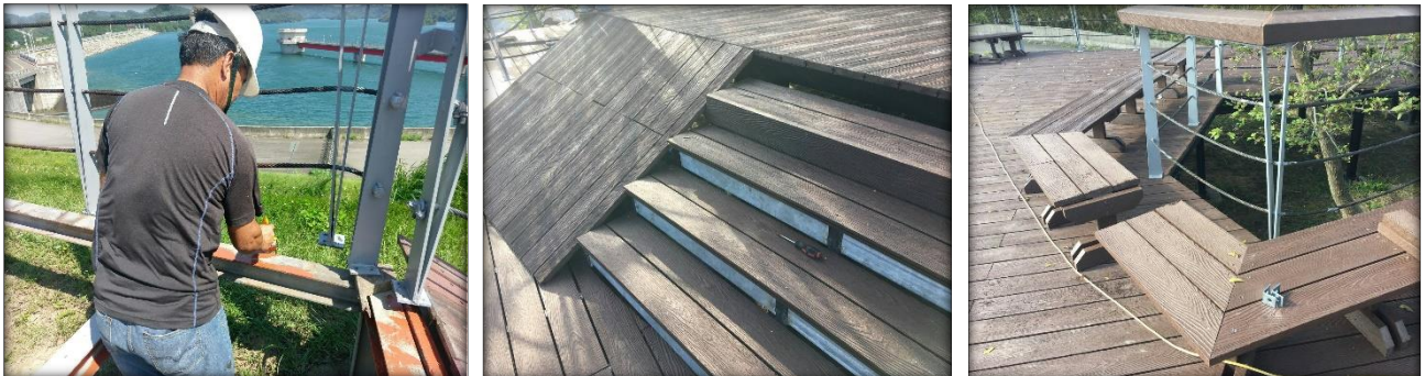
圖 10 塑木平台完工照片
