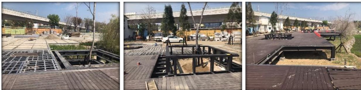
圖 7 塑木平台施工中照片
