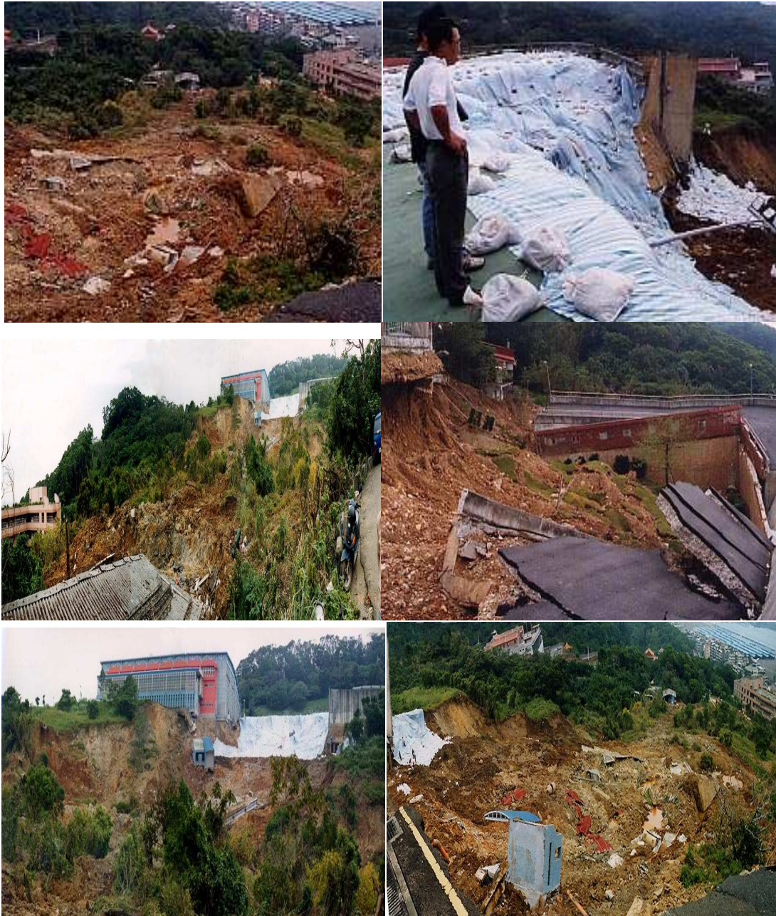
圖 3.2 國立台北藝術大學游泳館旁邊坡大面積崩塌 2001 年 9 月 29 日
