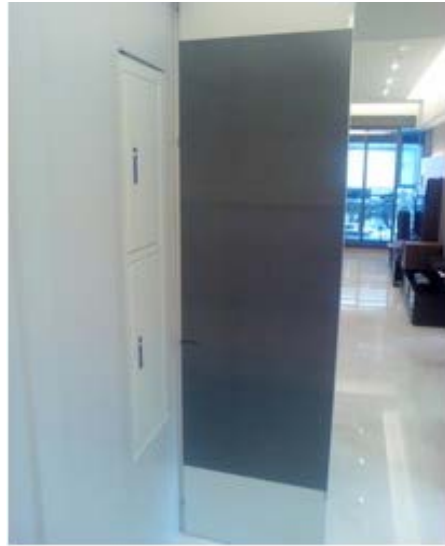
圖 1 總電箱低頻磁波測值 47.1mG 圖 2 門板內鋪低頻消磁板後測值 2mG
