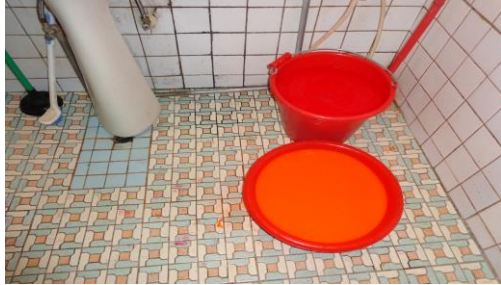
照片9 4樓浴廁使用紅色顏料水作試水
