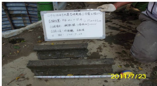
圖4、鋼軌樁障礙圖
