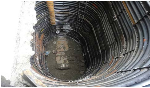
圖2、開設中間障礙井狀況圖
