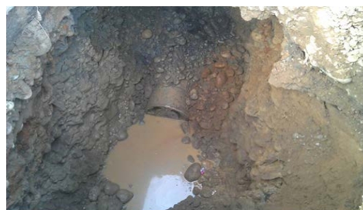
圖7、障礙開挖狀況圖
