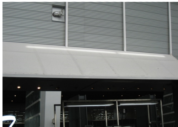
圖 11 增設遮陽板可有效阻絕下午大量日照光線直射。 (資料來源：本研究拍攝)
