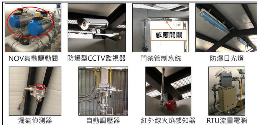
圖3 整壓站消防系統設施示意圖
