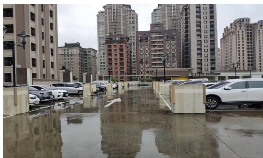
圖 3-11 屋頂層露天停車場 1
