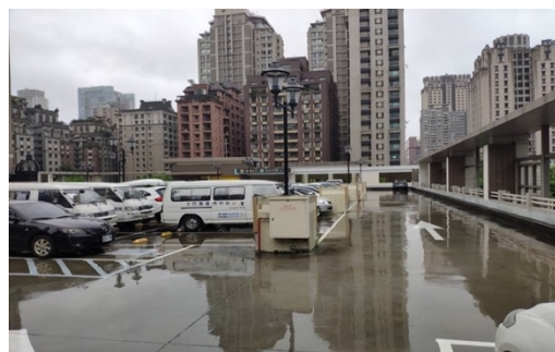
圖 3-12 屋頂層露天停車場 2
