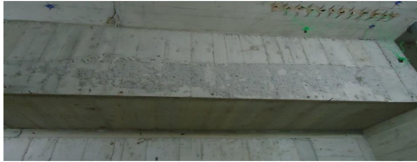
圖 8 模板未脫模油或未潤濕造成混凝土表面剝板
