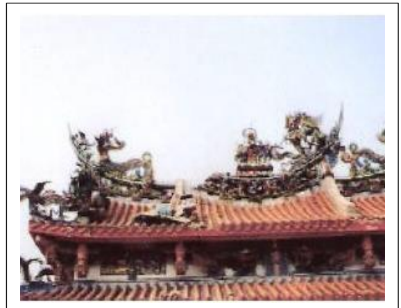
圖 3-2 民雄廣濟宮正脊左側損壞情況
