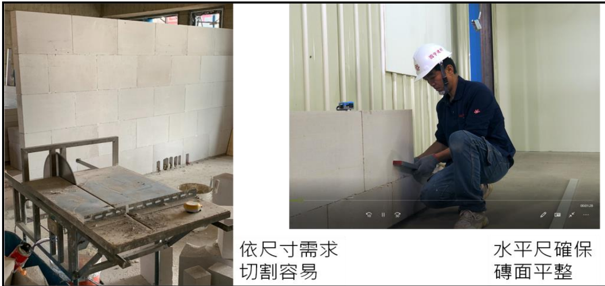
圖 5 高壓蒸氣養護輕質氣泡混凝土現場施工狀況[4]
