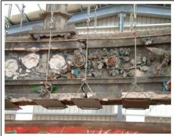
圖 3-1 台北集應廟正脊損壞情況
