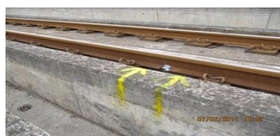
(a)鋼軌下翼版處黏貼光彈貼片
