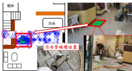
圖 8 民宅樓版污水管滲漏源檢測結果驗證
