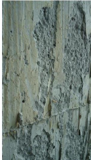
圖 4 模板未清潔乾淨及上油，造成混凝土剝皮
