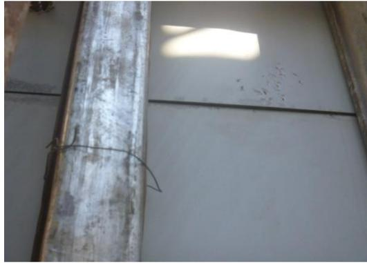
圖 8 模板支撐鋼性不足造成模板變形
