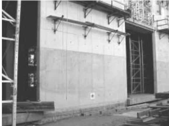
圖 19 木質模板造成混凝土表面色質差異及起粉 [6]
