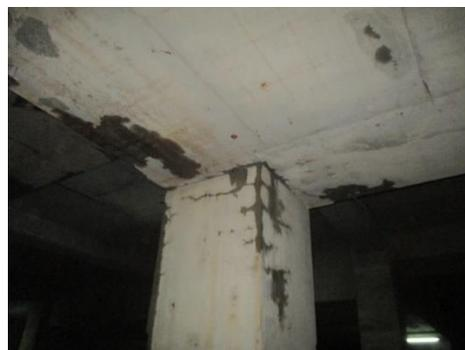
圖 13 過早拆除支撐導致柱板產生沖剪破壞裂縫
