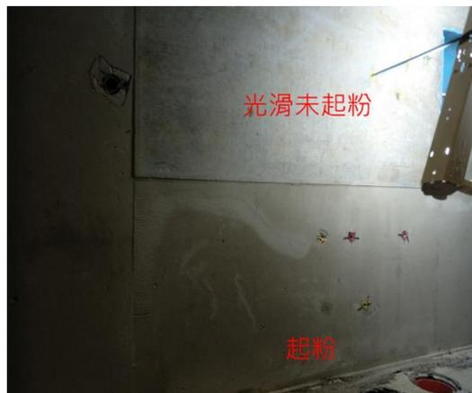
圖 20 同一次澆置的混凝土於局部模板處產生起粉
