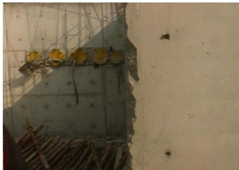
圖 12 過早拆模牆體產生掉角(資料來源:國產建材股份有限公司拍攝)
