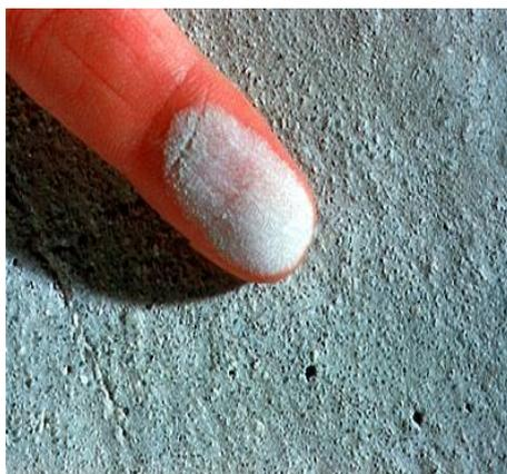
圖 21 混凝土板面起粉 [8]
