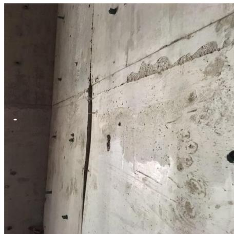
圖 10 混凝土牆面不平整產生錯位
