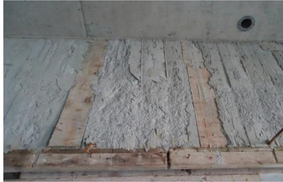
圖 2 模板老舊破損以薄木片修補，拆模後黏結於混凝土
