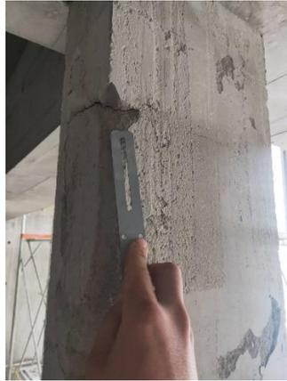
圖 6 鋁合金模板未清潔乾淨脫模產生混凝土表面缺失
