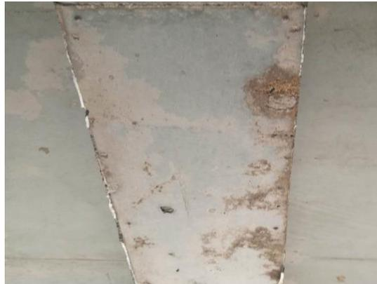
圖 14 梁底混凝土黏結雜物
