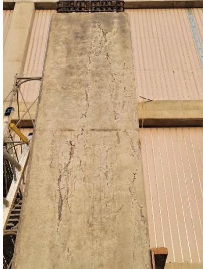
圖 17 混凝土獨立柱表面產生水痕紋路
