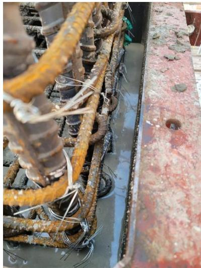
圖 18 混凝土鋼模獨立柱澆置後泌水
