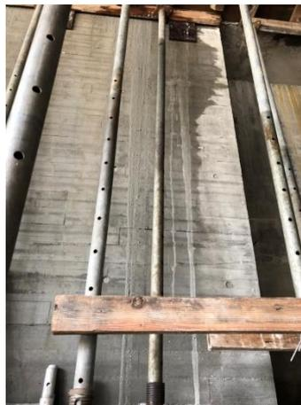
圖 9 混凝土澆置後產生漏漿污染混凝土面
