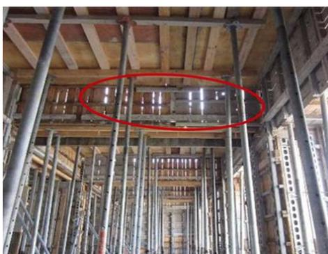
圖 1 模板間隙過大[4]
