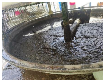
圖 5 冷卻水塔髒污示意圖
