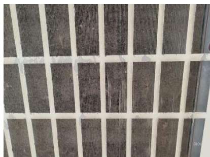
圖 4 冷凝器髒污示意圖
