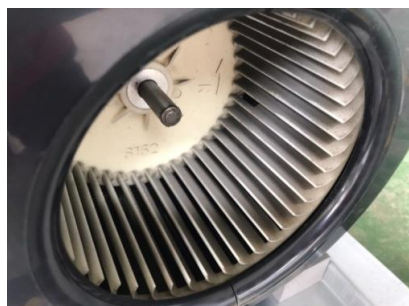
圖 6 送風機風鼓髒污示意圖
