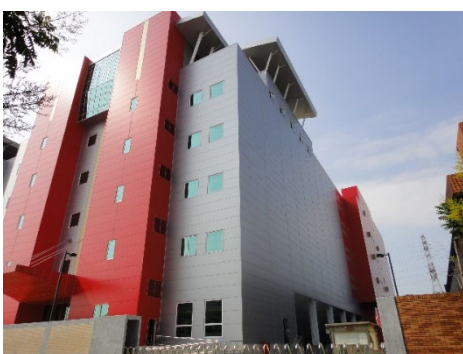
圖 1.2 三明治外牆立面橫鋪式廠房圖
