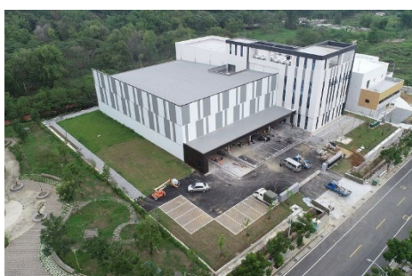
圖 1.1 三明治外牆立面直鋪式廠房圖
