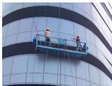
圖 12 吊籃作業 (外牆專業清潔公司提供)
