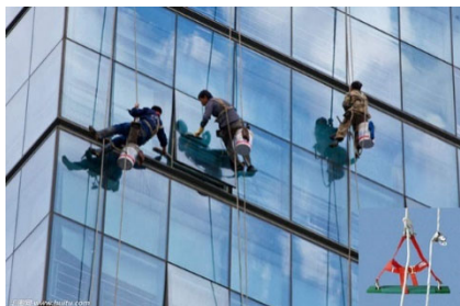
圖 11 吊板(繩)懸吊方式 (外牆專業清潔公司提供)
