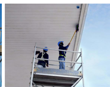
圖 15 移動式鷹架作業 (外牆專業清潔公司提供)
