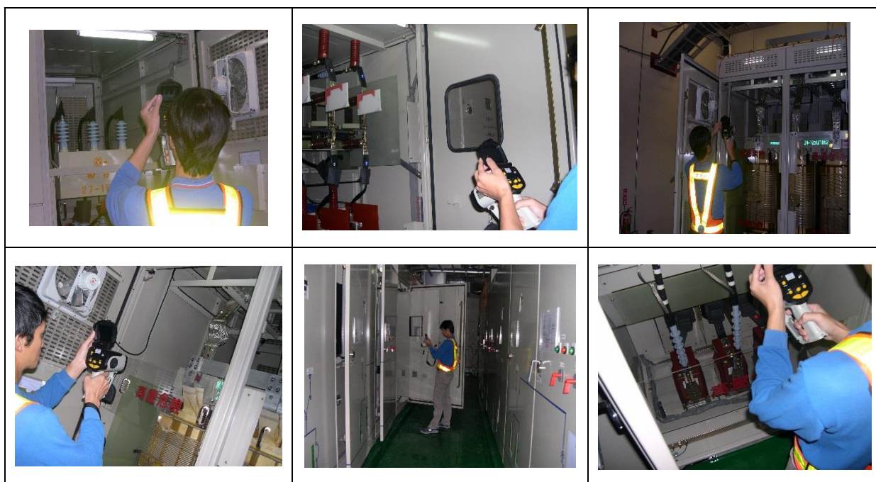
圖 4 不停電保養檢測高壓設備
