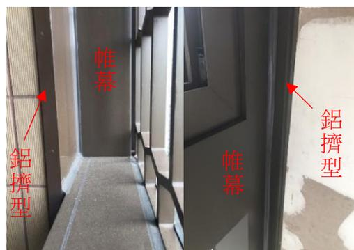
圖14 擠型2安裝完成照片
