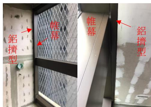
圖15 擠型3安裝完成照片
