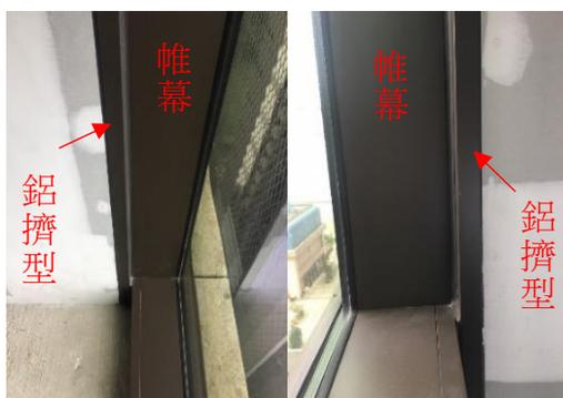
圖13 擠型1安裝完成照片
